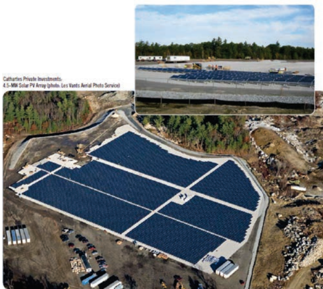
Рис. 3.67 Спорудження сонячних батарей на колишньому санітарному звалищі штат Массачусетс (США) [150]
