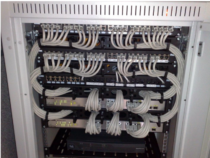
Рис. 3.1. Комутатори Gigabit Ethernet і комутаційні панелі
