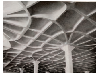
Залізобетонна конструкція (Пер Луїджі Нерві)
