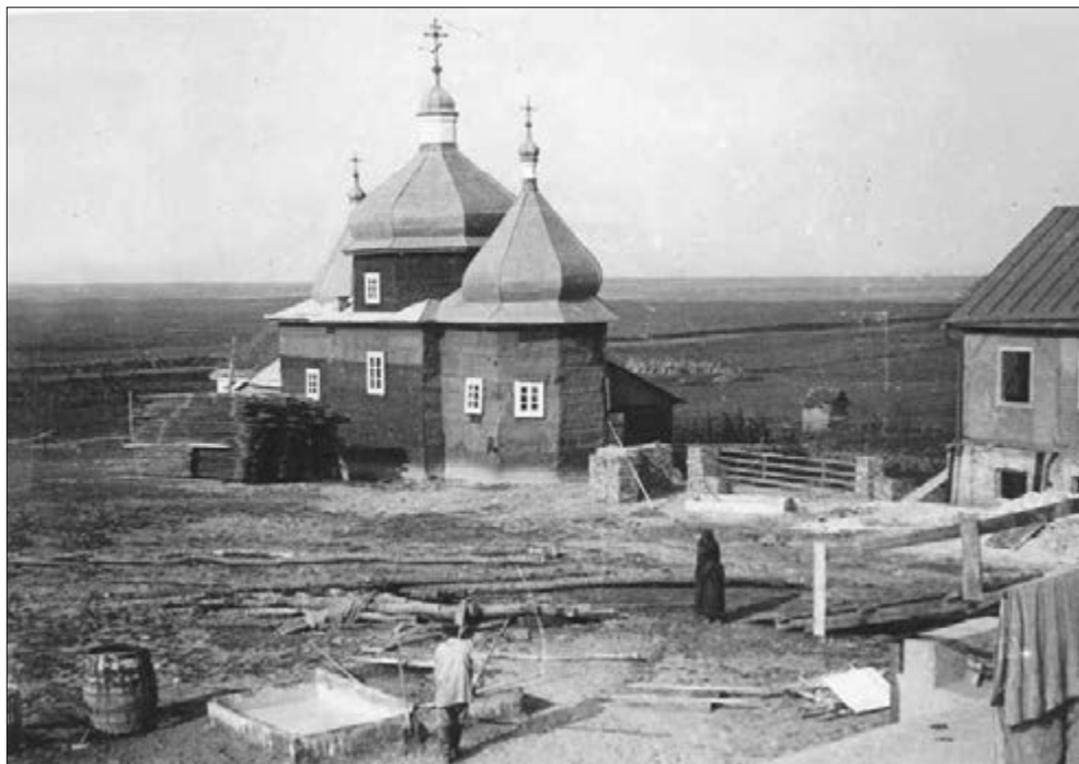
Будівництво меморіального комплексу «Козацькі могили». Фото 1913 р.
